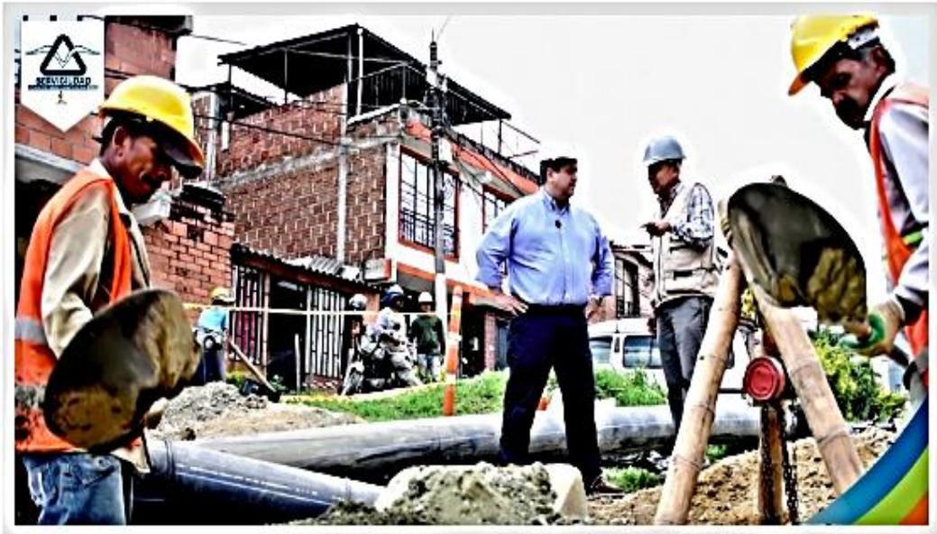
En estos momentos, estamos instalando una tubería en polietileno que permitirá suministrar 80 litros de agua potable por segundo, para mejorar en la calidad y continuidad del servicio.
